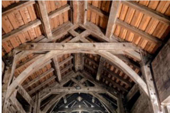
Heute wieder mit Schindeldach: Die Horbenbrücke wurde seinerzeit aus Feuerschutzgründen mit Eternitziegeln gedeckt.
