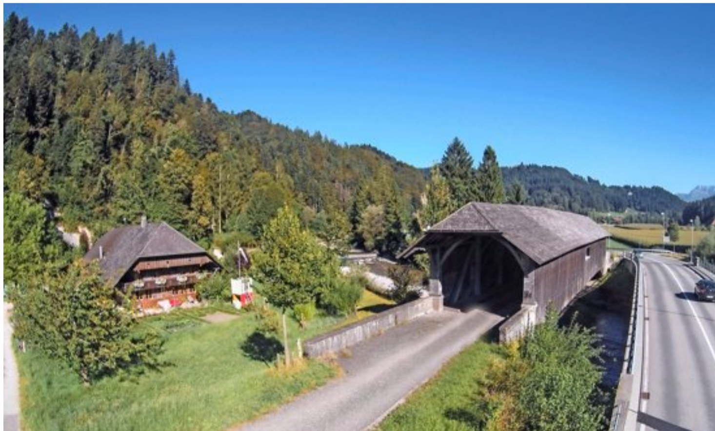
Dreispurig: Bis 2007 schleppten sich noch Lastwagen über die hölzerne einspurige Horbenbrücke in Eggwil. Bevor der zweispurige Betonübergang gebaut werden konnte, gab es einigen Zwist in der Gemeinde.
