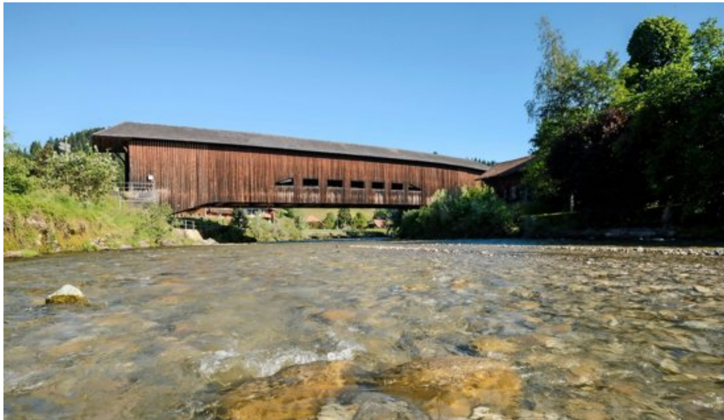
Bis vor gut 30 Jahren die einzige Verbindung zwischen Bern und Luzern für jene, die das Emmental durchfahren wollten: die Schüpbachbrücke.
