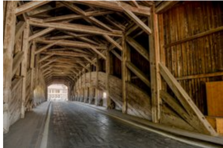
Andreaskreuze heissen die stabilisierenden Verstrebungen im Gebälk der Schüpbachbrücke, die Windstösse abschwächen sollen.
